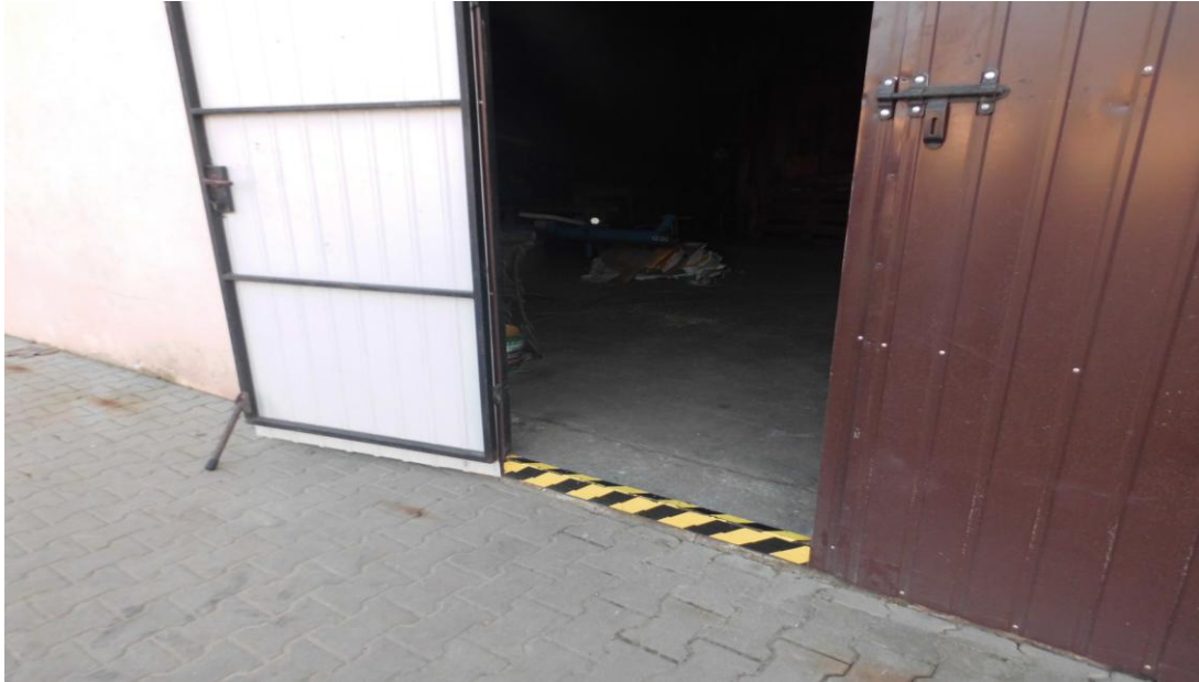
Foto KRUS: Prawidłowo oznaczony próg.
